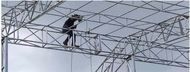
사진 Ⅲ-2 전신주 높이의 고공(지붕에서) 아무런 안전 장치 없이 일하는 모습
